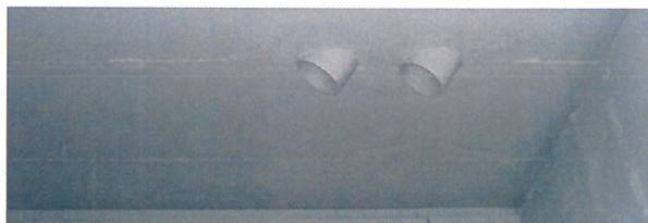
Figura 8: fori grezzi per il passaggio dei tubi isolati, predisposti sul soffitto del locale S018 (codice originario A6).
