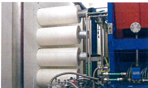
Figura 9: esempio di installazione dei tubi isolati per la facility HRIBF (TN, USA).
